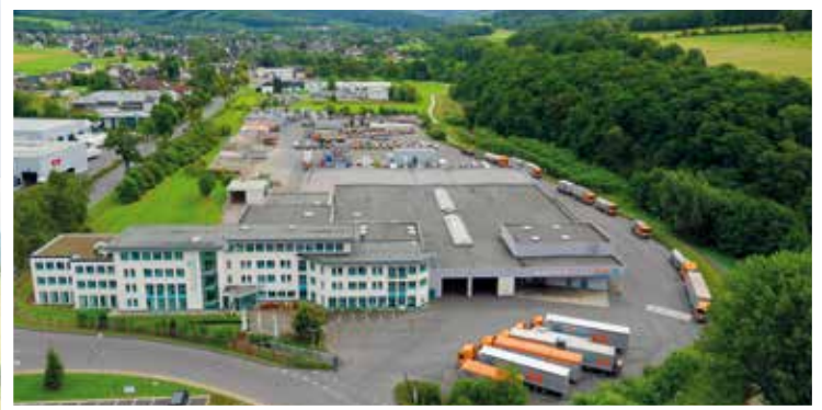
Verwaltung und Dienstleistungscenter (DLC)
