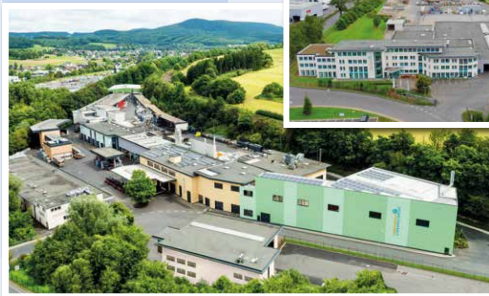
Abfallbehandlungsanlage – Entsorgungcenter (ESC)
